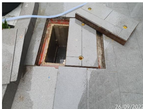
รูปที่ 36 บ่อพักน้ำภายในโครงการ
